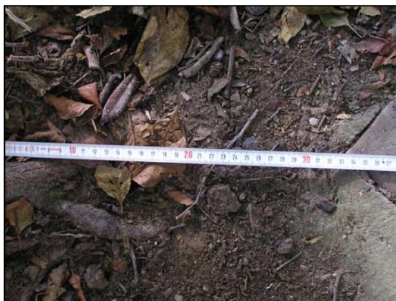
Betonozás a fa gyökerétől 20 cm-re
