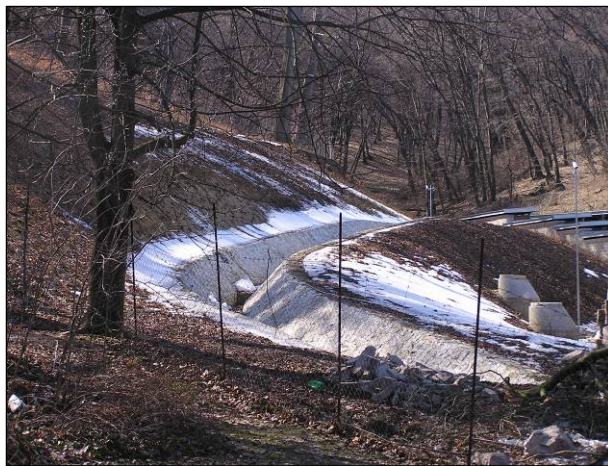
Csapadékvízvezető a fürdő fölött
