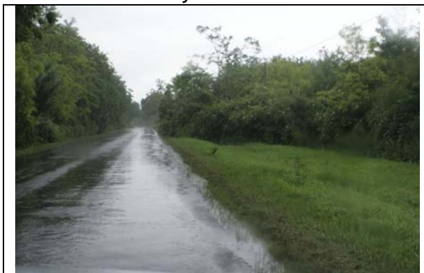
Kétegyháza és Elek között tervezett kerékpárút leendő nyomvonala
