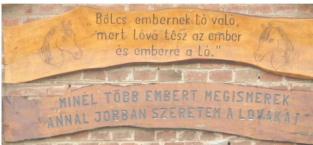
Tégla ornamentikás csűr és istállóépület ásott kúttal a 6. sz. lakóépület udvarán A csapadékvíz elvezetést ki kell építeni. Megtartandók.
