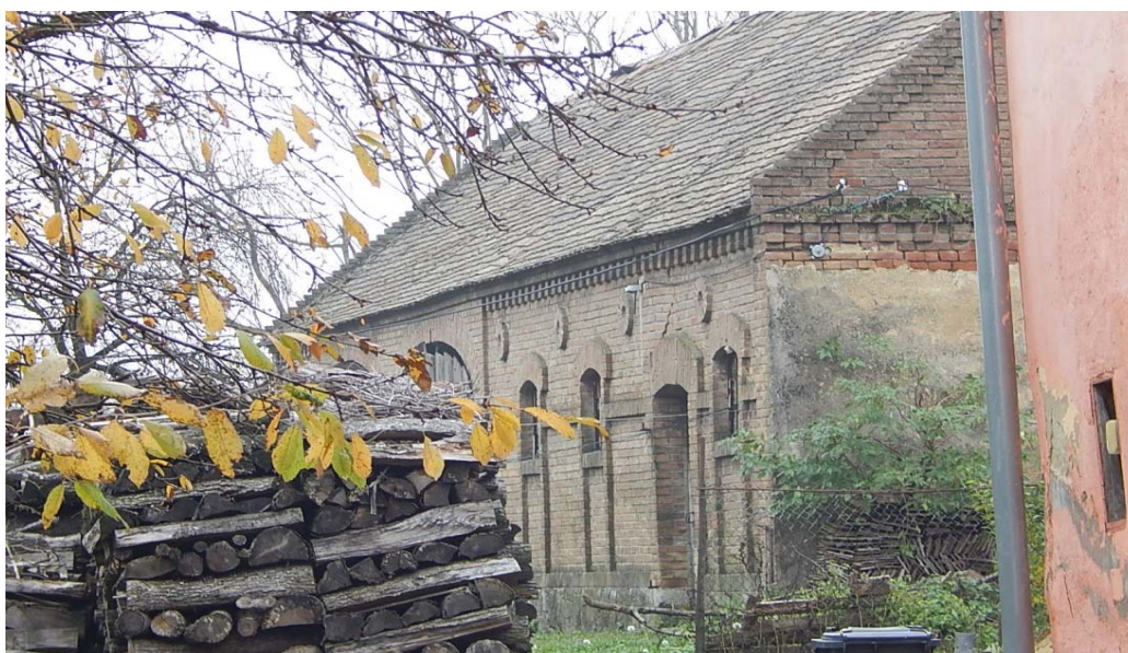
Átépített utcafronti épület korabeli natúr téglá istálló épülete. Fő u 46 A melléképület tömege, arányai, nyílásrendje, a látszótéglás felületekkel megtartandók.
