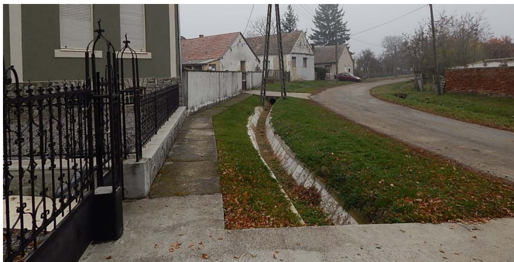
Fő u. 28. falazott utcai kerítés, 29. kovácsoltvas kerítés, megtartandók .
