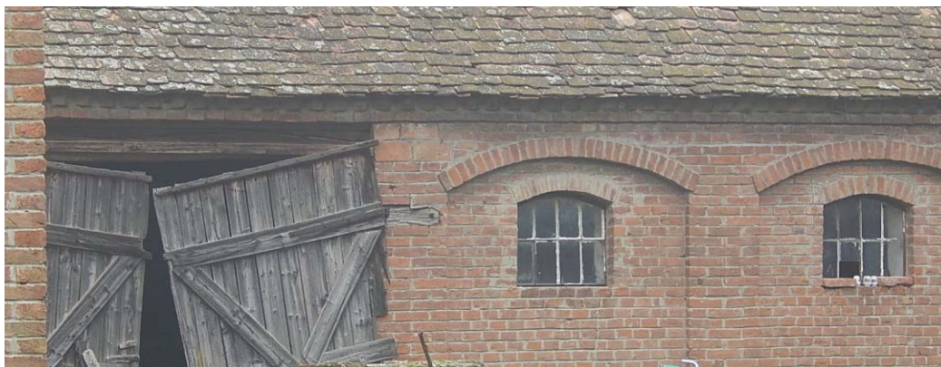
A Fő utca 23. számú saroktelek a 20. sz. első felében épült natúr téглаornamentikás melléképületeivel és kovácsoltvas kerítés-kapuval, amely felújítandó , az istálló ajtóval együtt. A melléképületek tömege, arányai, nyílásrendje, látszótéglás felületeivel megtartandók.
