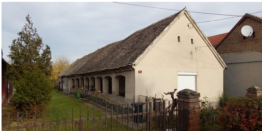
A Kossuth Lajos u. 59. szám alatti népi lakóház szegmensíves „lopott” tornáccal. A főhomlokzat eredeti nyílásrendszerét régi fotók, falkutatás, vagy analógiák alapján helyre kell állítani. Megtartandó.
