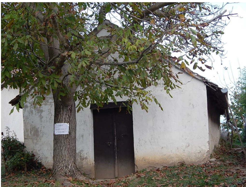
Girótfá présház-pince tömegét változatlanul kell hagyni, a homlokzat meszelését fel kell újítani.
