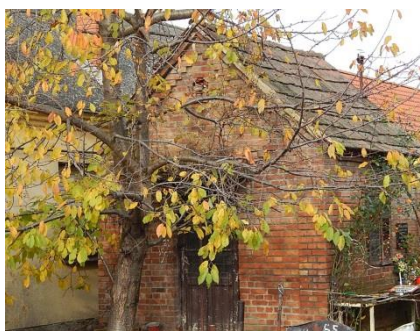
A Kossuth Lajos u. 65. szám alatti népi lakóház az ellentétes telekhatárra épült natúr téglá melléképülettel településképi történeti érték. A homlokzatokat világos színnel fel kell újítani és a csapadékvíz elvezetést kiépíteni.
