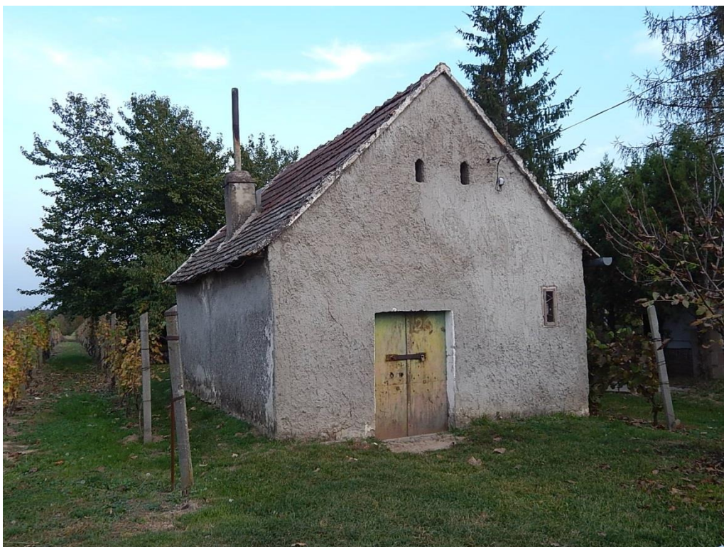
Girótfá présház-pince, a korabeli homlokzatfestés helyreállítandó.
