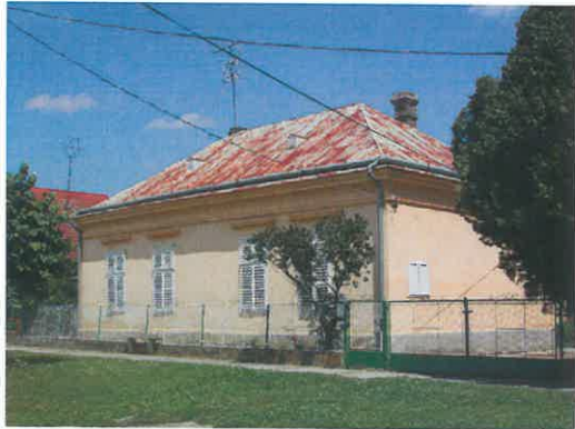
14./ Lakóház Szabadság u. 25. HRSZ : 77 H1
