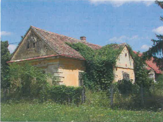
13./ Lakóház Szabadság u. 24. HRSZ : 76 H1
