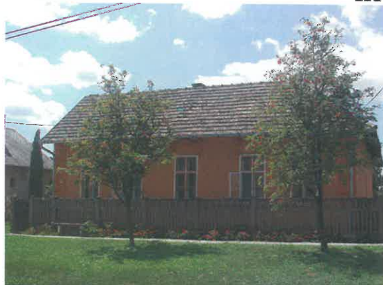
16./ Lakóház Szabadság u. 63 HRSZ : 114 H1
