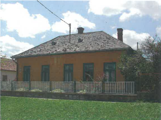
15./ Lakóház Szabadság u. 56. HRSZ : 107 H1
