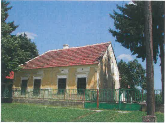
11./ Lakóház Szabadság u. 13 HRSZ : 64 H1
