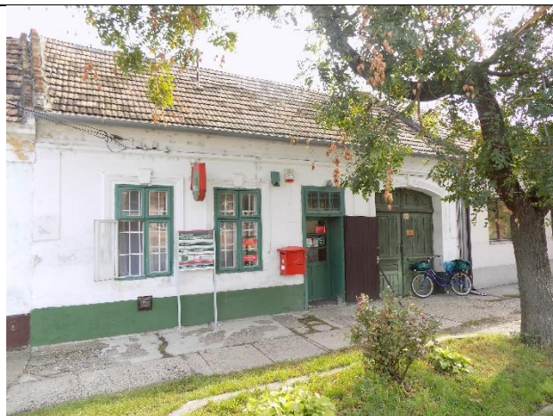
Posta épülete Szabadság utca 37.
