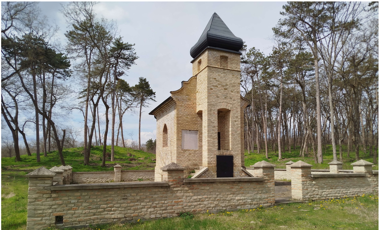
A felújított kápolna
