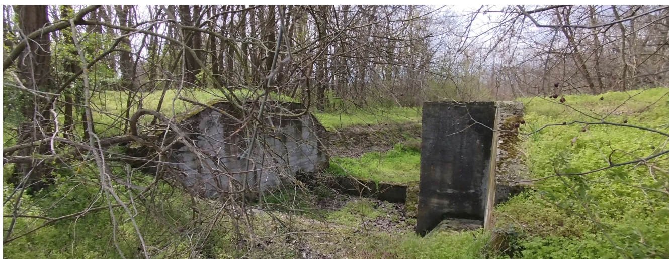
Árapasztó műtárgy a tó kifolyásánál
