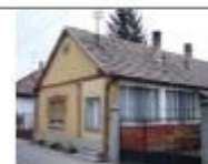
hrsz.: 1897, átépített, verandás lakóház, karakterszerű beépítés
