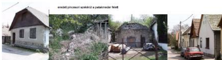
Utcaiép utcánk merőleges gerincű nyeregtetős házaival
