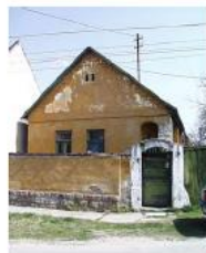
hrsz: 1961, karakteres lakóház, beépítés, faragott kőküpu, deszkabélétek
