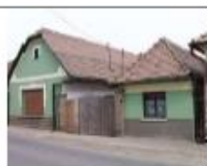
h.sz.: 2297, lakóház, karkiteres belsőp
