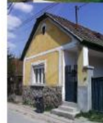
hrsz.: 1952 karakteres tornácos lakóház, eredeti beépítés
