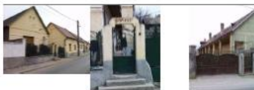
h.sz.: 2259, tornácos lakóház, eredeti karakters beépítés, feregott kőkapu 1977-ből
