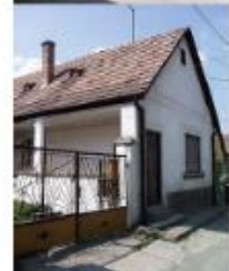
hrsz.: 1909; karakteres tornácos lakóház, eredeti beépítés
