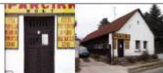
hrsz.: 1884, karakterszerű tornácos lakóház, karakterszerű beépítés és kőkapu
