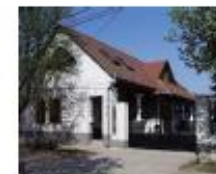
forrás: 1718, hosszalosa eredeti bejárat, karakteres tornácos porszifár, értékes felújítás
