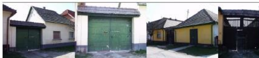
h.sz.: 1779, lakóház, karakteres fe nagykapu h.sz.: 1784, lakóház, karakteres fe nagykapu
