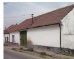
h.sz.: 2290, lakóház, zártkörű beépítés, karakteres kapu
