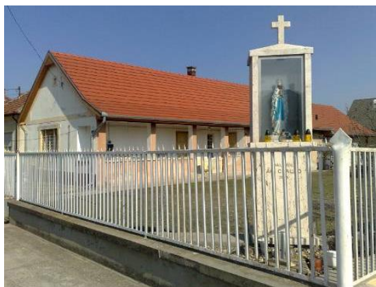
14. Iskola utca 3/1. Lakóház (hrsz.: 931/1)
