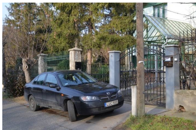
Árpád u. 25. részben helyreállított kerítés, 2013.
