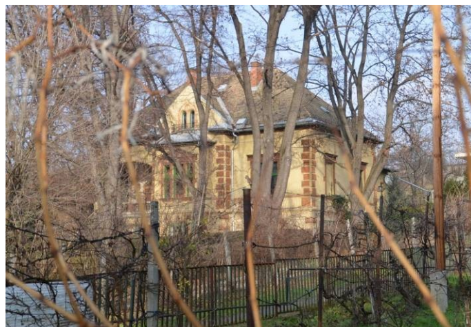
Walla-villa az Árpád u. 21. felől, az eredeti telek megosztásával kialakított magánút
