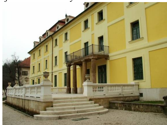
kastély, homlokzati részletek
