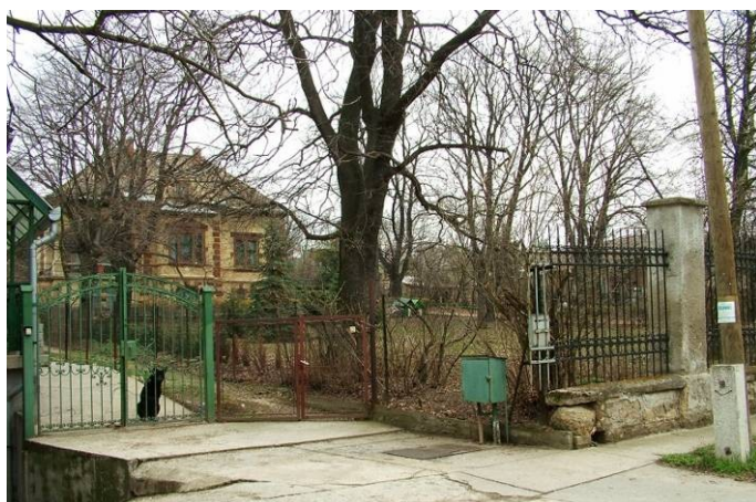
Árpád u. 25. megbontott kerítés, 2009.
