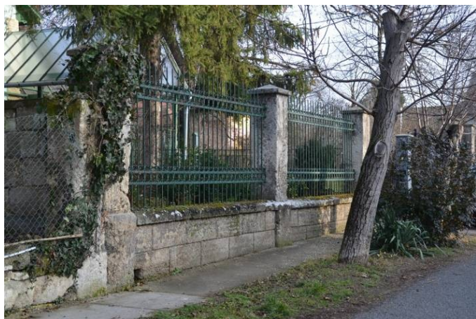
Árpád u. 25. kerítés
