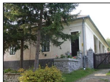
6. Római Katolikus Parókia épülete Hunyadi u. 70. sz. (hrs.: 84)
