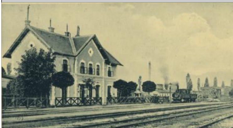
Fotók (építés-2012 között)
