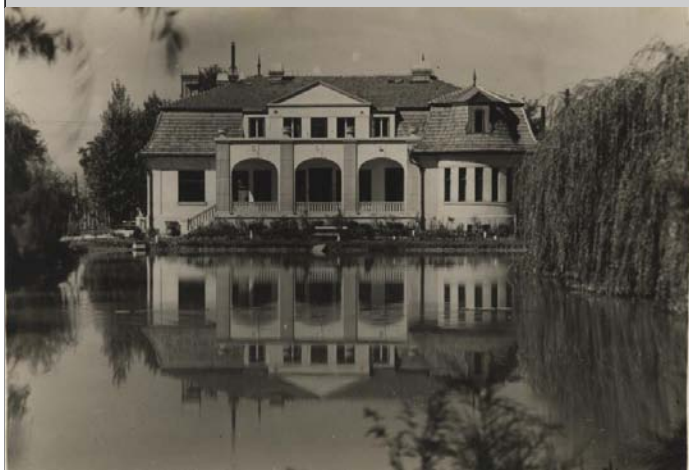
Fotók (építés-2012 között)
