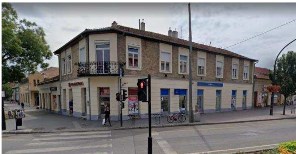
Az épület jelenlegi állapota
