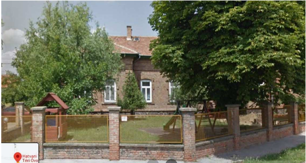
Az épület jelenlegi állapota
