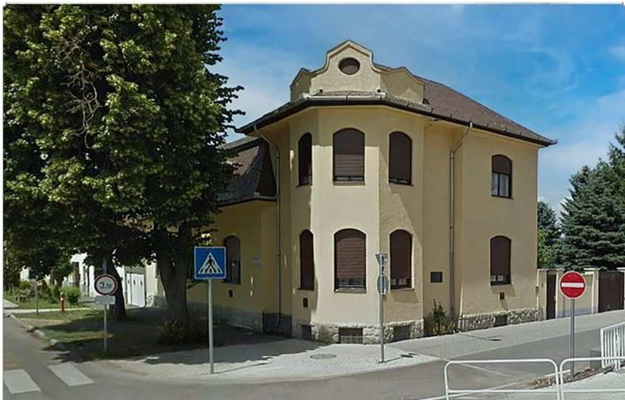
Az épület jelenlegi állapota
