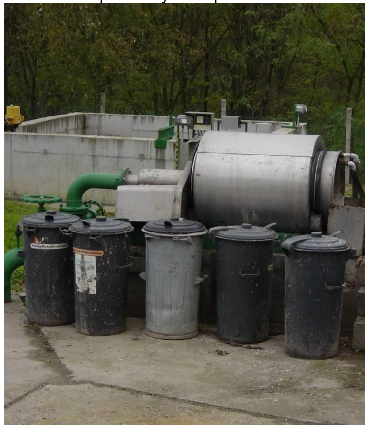
10. kép: Szennyvíztelep – Durva rác
