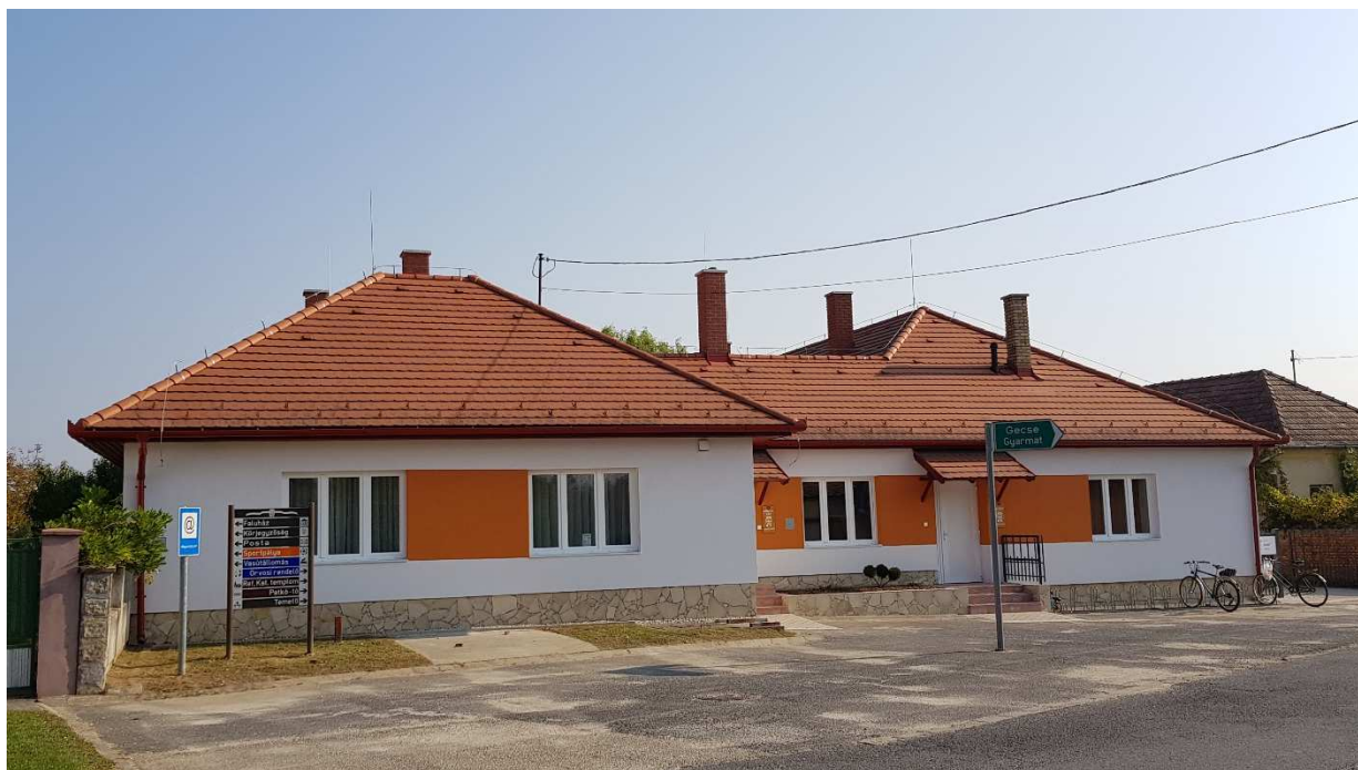
Óvoda épülete: Széchenyi u. 8. (Hrsz.: 6.)
