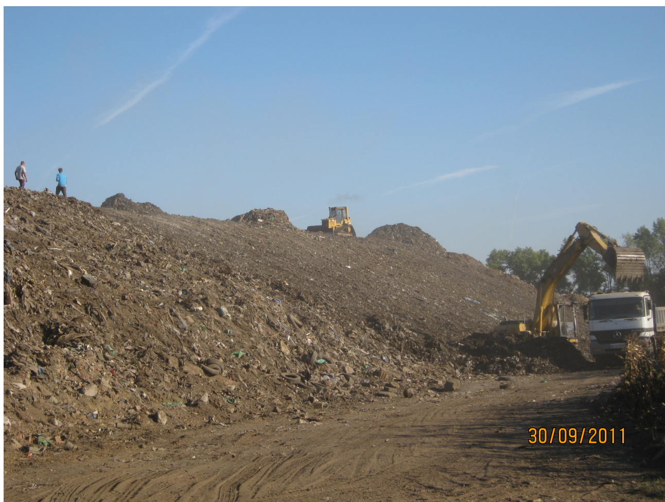
Kiegyenlítő réteg felhordása a Gyöngyös-majori hulladéklerakóra
