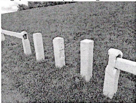
Régi (XX. sz. közepe) országúti betonkorlát
