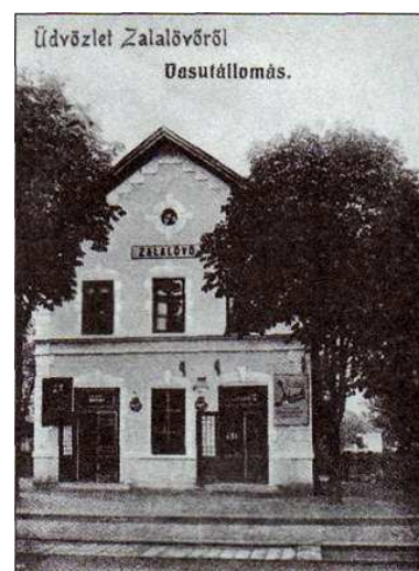
Vasútállomás a 20. század közepén
