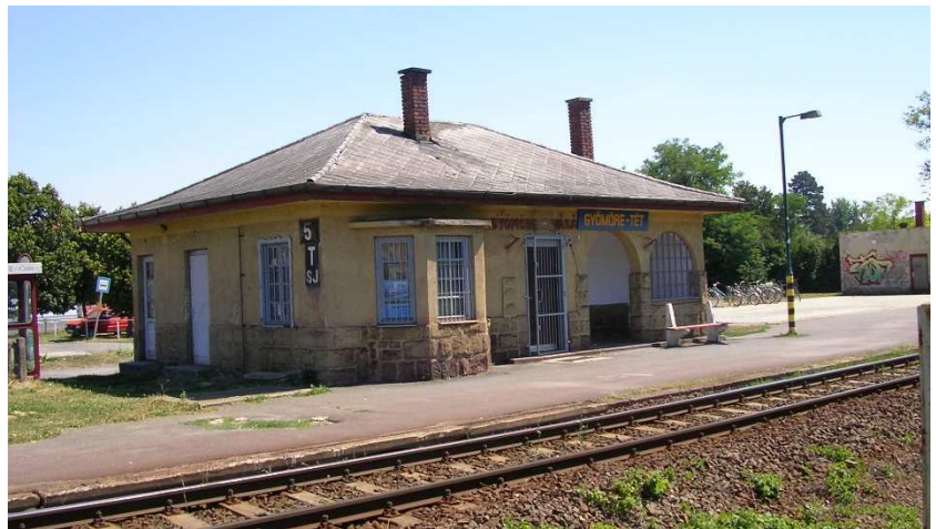
Vasútállomás épülete: 331/3 hrsz, Martinovics I. u.
