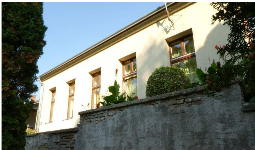
Alsó iskola 155 hrsz, Rákóczi Ferenc utca 6-8.
