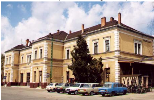
18. MÁV Állomás épülete (Pillangó utca 21.)
